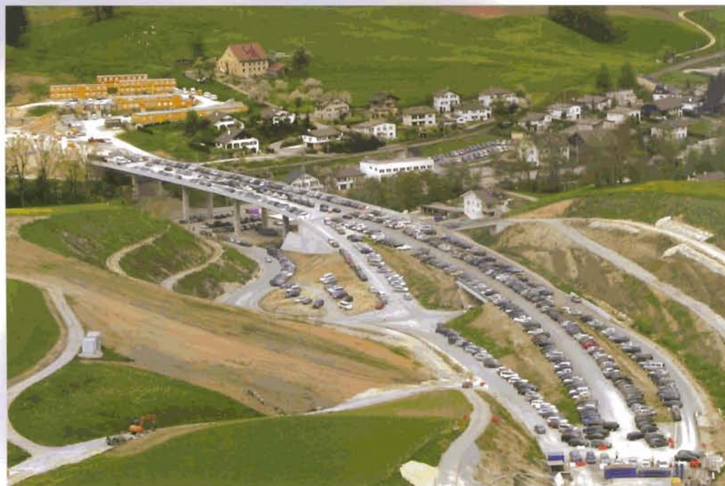
Parking du SIAMS: une bretelle d'autoroute non encore en service...
